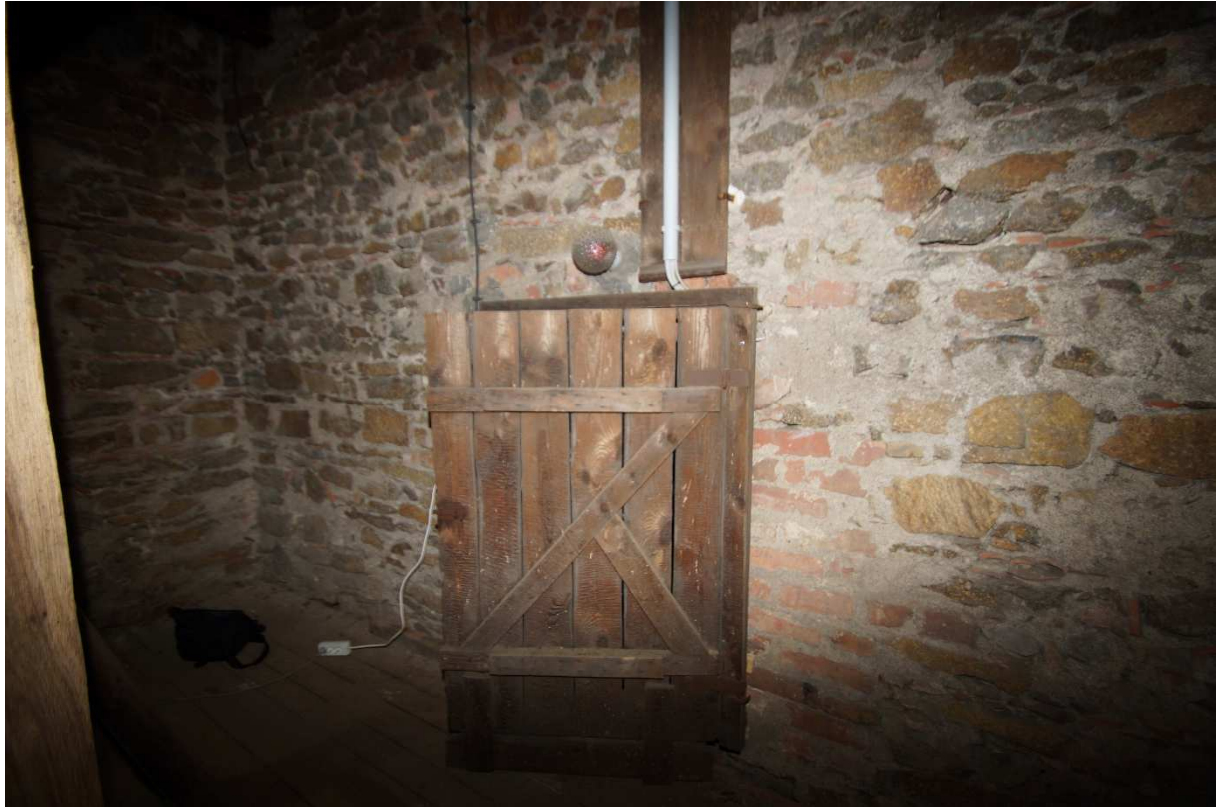
Zugang über die Bretttertür in den Glockenturm. Die rote Lampe über der Tür signalisierte dem Kirchdiener, wann zu läuten ist (Fernbedienung).
