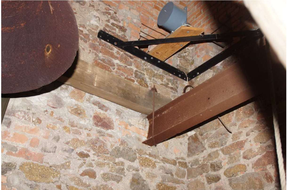
Glockengerüst, bestehend aus horizontalen Doppel-T-Träger, horizontalen Holzträgern 8 x 14, oben der Motor der Schwenkmechanik, grau erkennbar.
