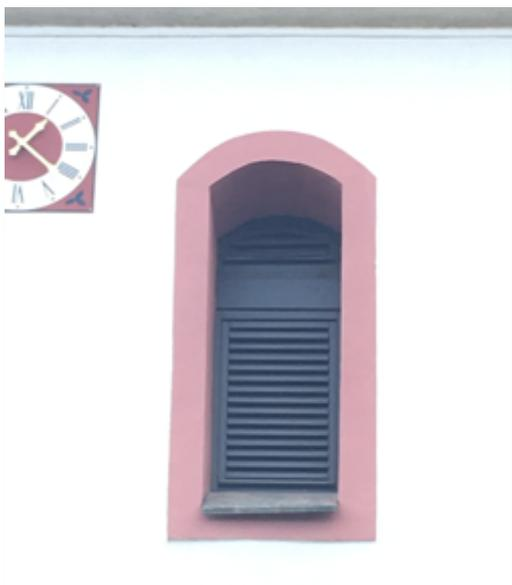
Eher unscheinbar geben sich die neuen Schalljalousien für das Geläut. Sie schützen das Turminnere vor Witterungseinflüssen und sind so gearbeitet, dass der Schall nach unten getragen wird. Herzlichen Dank denen, die sich für diese Bauaufgabe eingesetzt haben. Ebenso gab es kleine Putzausbesserungen im Inneren der Lutherkirche. Auch dafür vielen Dank!
